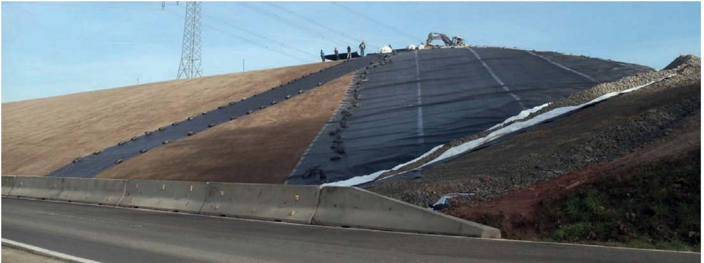
Deponie Sendelbach in Lohr am Main – Bau einer Oberflächenabdichtung mit Kunststoffdichtungsbahn
