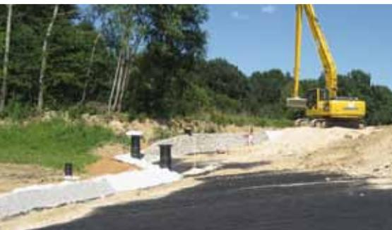
Einbau der Flächendrainage und der Rekultivierungsschicht
