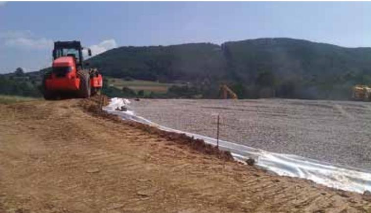
Einbau der ersten Lage der mineralischen Dichtungsschicht
