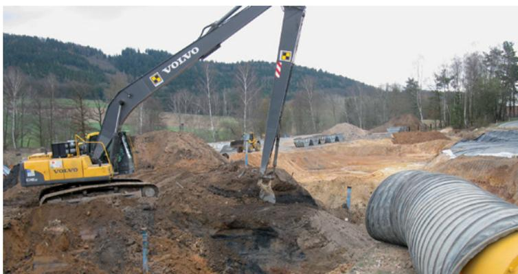
**Abb. 5: Aushubarbeiten mit einem Longfront-Bagger; im Vordergrund Bewetterungsanlage**
