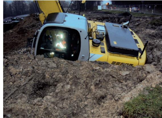
**Abb. 4: Baggereinbruch bei Erdarbeiten über einer zuvor nicht bekannten Säureharz-Grube**
