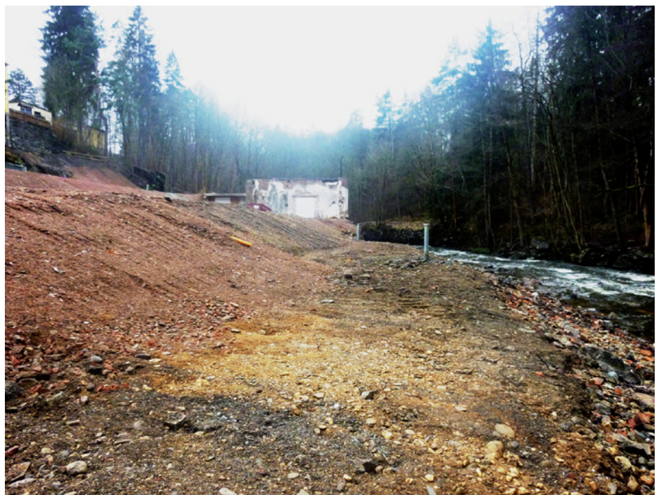
Standort des Presswerks Elisenfels nach Abschluss der Geländefreimachung mit Bodensanierung.
