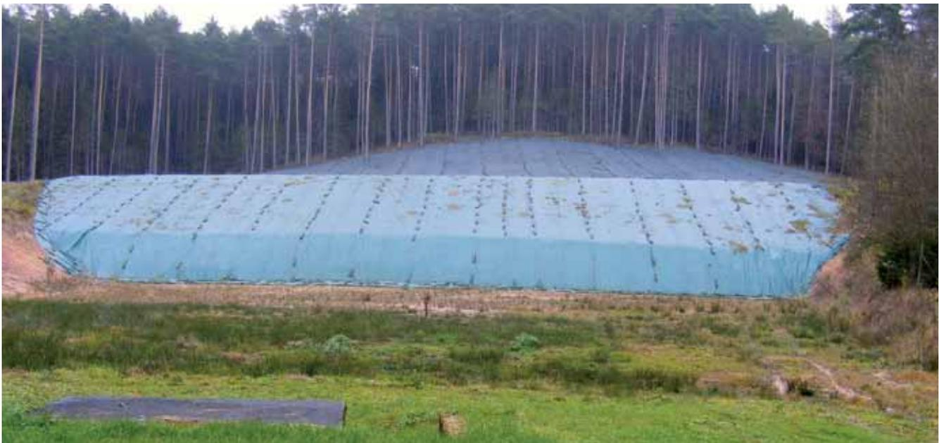
Wurfscheibenschießanlage des Bay. Jagdschutz- und Jägerverein e. V., Lichtenfels, flächiger Schrottfang mit Netzbelegung
