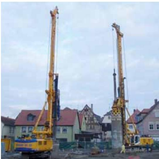
Bodenaustausch mittels Großlochbohrungen
