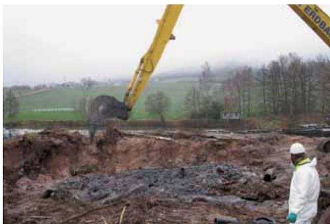
Bodenaushub Säureharzdeponie mit Longfront-Bagger
