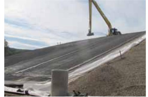
Verlegung der geosynthetischen Tondichtungsbahn (Bentonitmatte)
