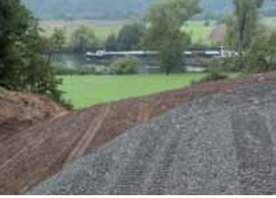
Ausgleichsschicht über dem Deponieplanum
