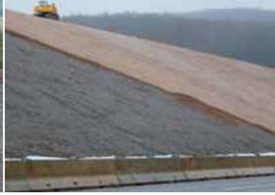
KDB-Auflager über Ausgleichsschicht
