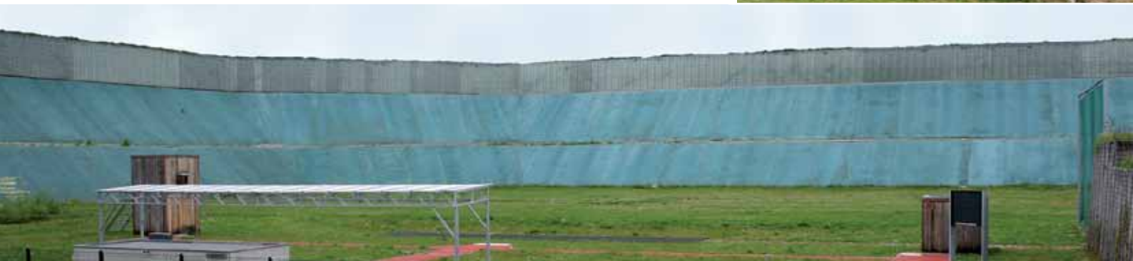
Abb. 2: Beispiel Erdwall (belegt mit Netzen und aufgesetztem Gabionensystem) bei kombinierter Trap-/Skeetanlage Olympiaschießanlage Garching (Bayern)
