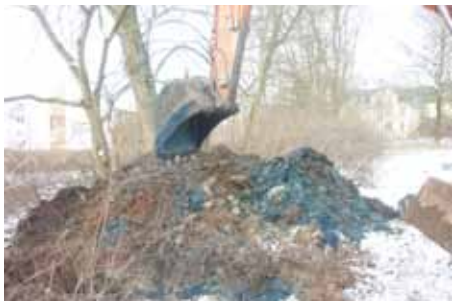
Aushub aus Baggerschürfen mit Cyanid-typischer Blaufärbung
