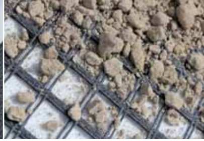
Geogitter auf Drainmatte mit Rekultivierungsboden (untere Lage)
