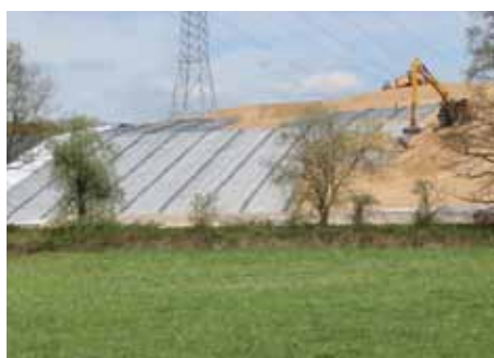
KDB, Drainmatte, Geogitter, Rekultivierungsboden (von links nach rechts)
