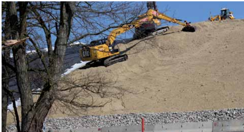
Einbau Rekultivierungsboden (untere Lage)
