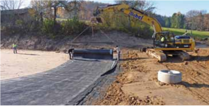
Verlegung der geosynthetischen Tondichtungsbahnen (Bentonitmatten)
