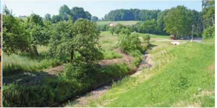
Gesicherte Böschung und renaturierter Grabenverlauf im Nordteil
