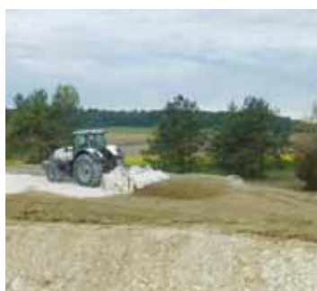
Aufbereitung des Dichtungsmaterials
