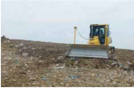
Profilierung mit GPS-unterstützter Raupe
