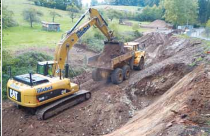
Dekontamination im Nordteil
