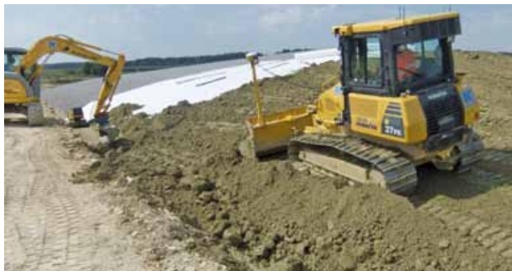
Einbau der Dichtungsschicht, Vliesverlegung
