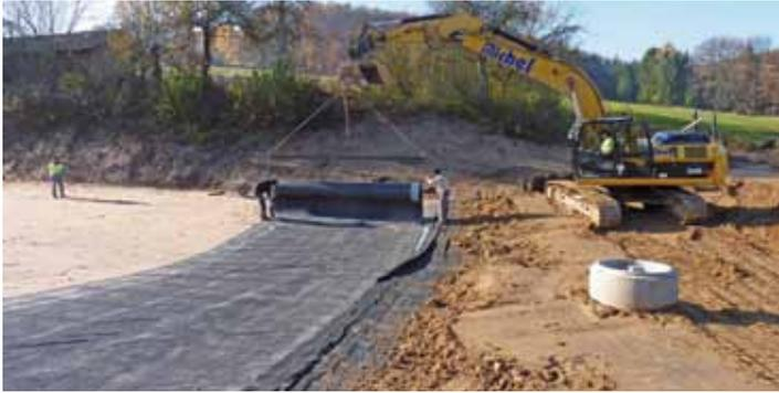
Verlegung der geosynthetischen Tondichtungsbahnen (Bentonitmatten)
