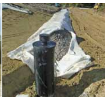
Herstellung Entwässerungsgraben
