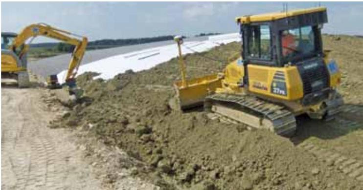
Einbau der Dichtungsschicht, Vliesverlegung
