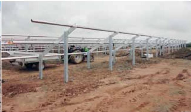
Unterkonstruktion für PV-Module
