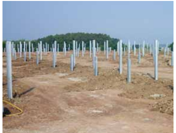
Streben auf Betonfundamenten
