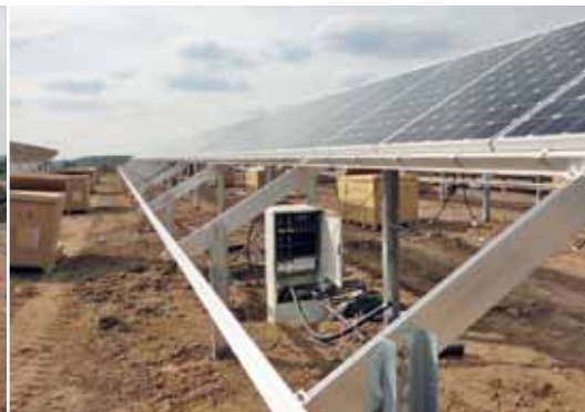
Montage der PV-Module
