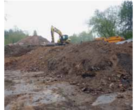
Dekontamination durch Aushub der belasteten Auffüllungen. Aufgrund der sehr inhomogenen Ablagerungen war eine schichtweise Aushubtrennung nicht praktikabel. Ausgehend von den Belastungsprognosen der Voruntersuchungen wurden daher genetisch vergleichbare Ablagerungszonen zu Aushubchargen zusammengefasst.
