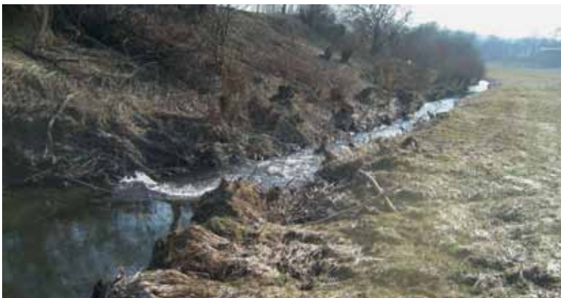
Katzbach direkt unterhalb der Deponieböschung vor der Sanierung
