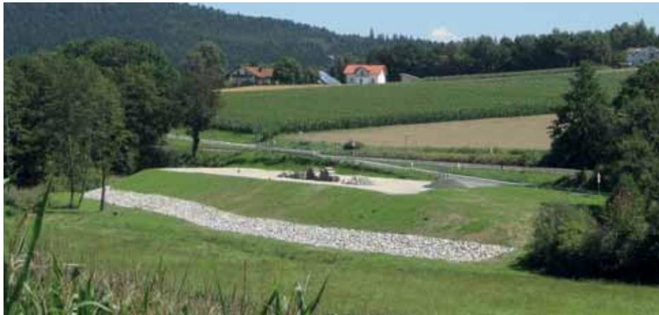
Fertiggestellte Deponiesicherung mit Erosionsschutz und Lagerplatz
