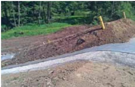
Probefeld mit Abdichtungsaufbau
