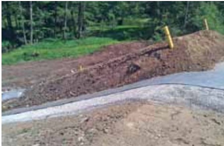
Probefeld mit Abdichtungsaufbau
