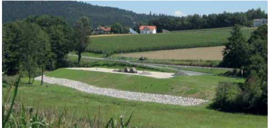
Fertiggestellte Deponiesicherung mit Erosionsschutz und Lagerplatz
