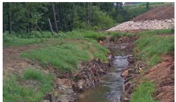
Renaturierter Bachlauf ca. 4 Wochen nach Umverlegung
