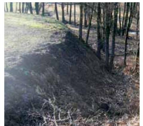
Deponieböschung vor der Sanierung mit zu starker Böschungsneigung
