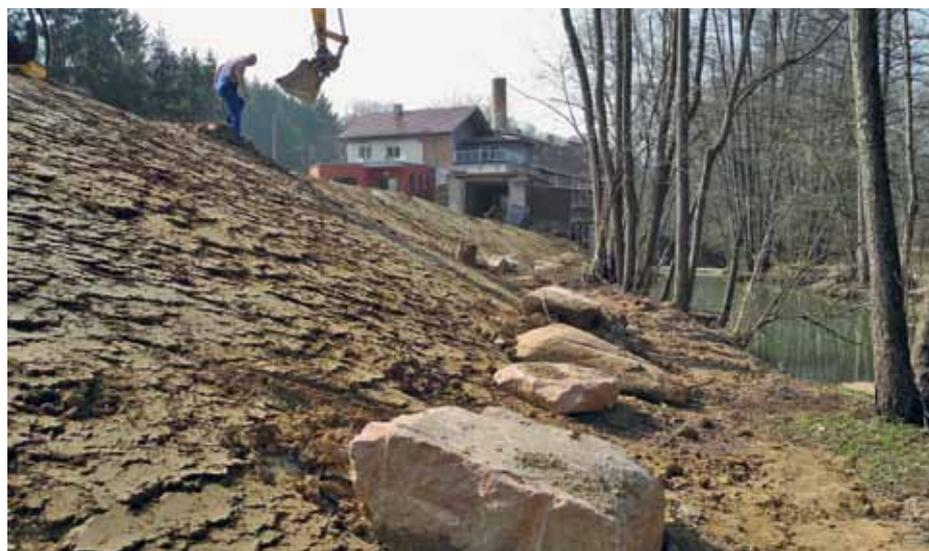
Zum Abschluss der Sanierung wurden die Baugruben mit schwach belasteten Aushub der Sanierung (Z 0 / Z 1.1 nach LAGA Boden) sowie mit Böden aus der Umgebung aufgefüllt. Die neue Hochfläche im Höhengniveau der Bestandsgebäude wird zur Wern hin von einer Uferböschung begrenzt, die in einen Uferstreifen ausläuft. Im Aushub wurden Felsblöcke aus dem ortstypischen Buntsandstein separiert und als Strukturelement bzw. Erosionsschutz am Böschungsfuß eingesetzt.
