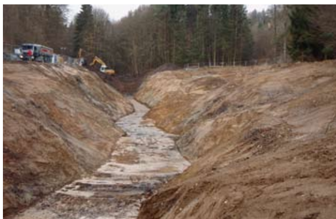
Pitzalsgrund nach Abschluss der Sanierungsmaßnahmen und ingenieurbioologische Hangsicherung mit Weidenfaschinen
