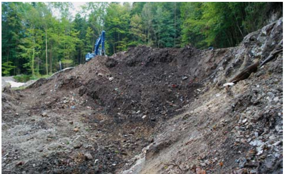
Abgrabung des Deponiekörpers
