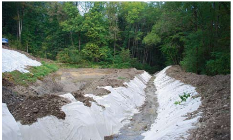
Fassung des Tennbodenbaches durch den Sedimentfang in einem provisorischen Gerinne aus Bentonitgewebe
