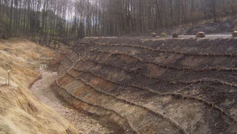
Die Sanierung erfolgte durch vollständige Abgrabung des Deponiekörpers
