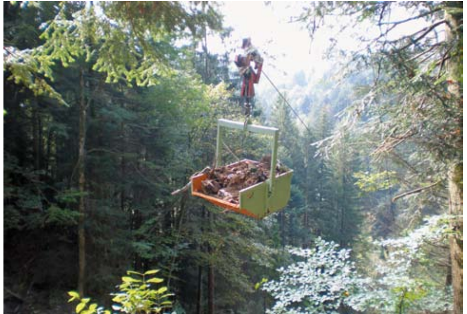
Bergung des verunreinigten Aushubmaterials im Baufeld (Abb. 1)
