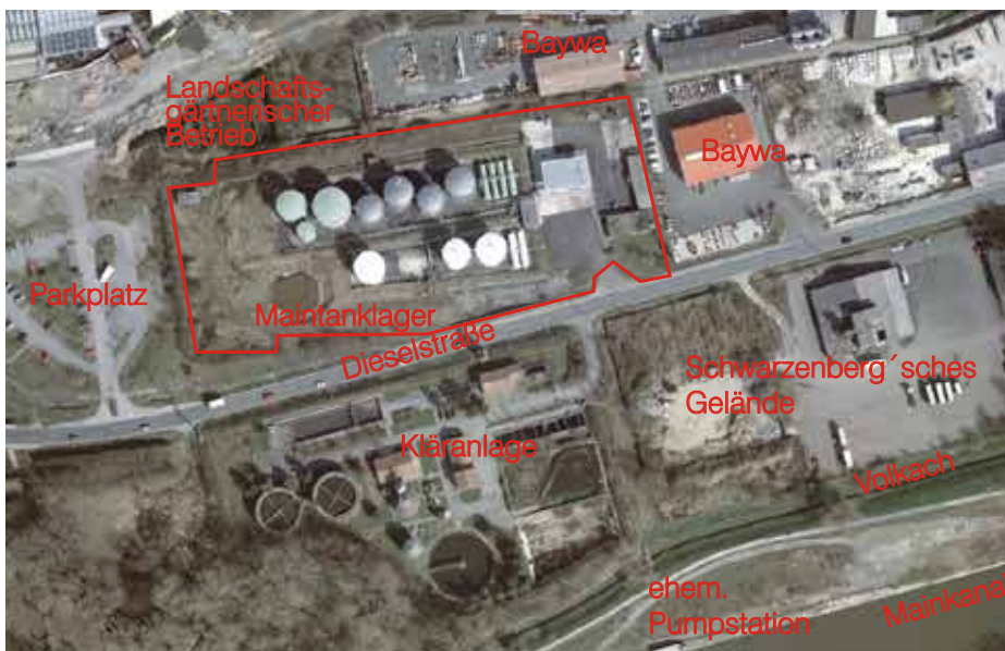
Luftbild des Tanklagers von 2008 (Bild 1)
