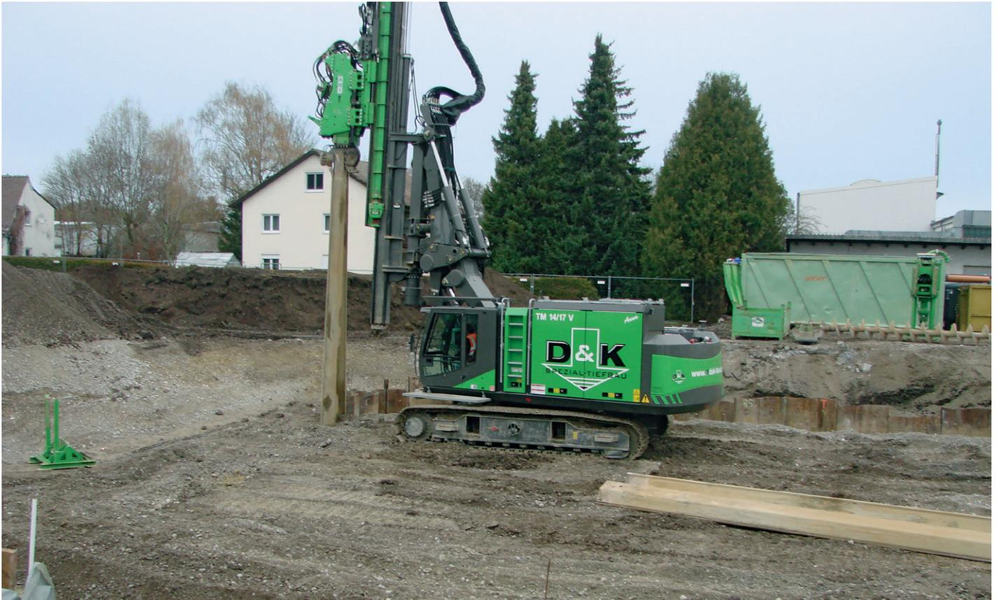
Rammarbeit für den Spundwandkasten (Bild Geiger Umweltsanierung GmbH & Co. KG)
