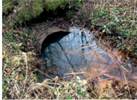
Altes Entwässerungsrohr mit ungewollter Drainagewirkung im Deponiekörper
