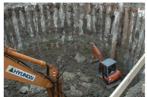
Abb. 2: Aushub des Eintragsbereichs innerhalb einer Bohrpfahlwand
