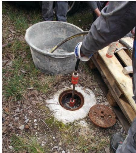
Abb. 4: Doppelpacker zur Einbringung der Melasse
