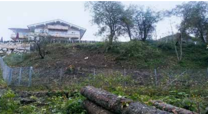
Baufeld nach Freischneidung, zentral der bereits abgerutschte Müllkörper
