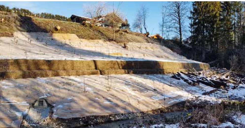
Fertigstellung Böschungssicherung mit Erosionsschutzmatten und Bepflanzung
