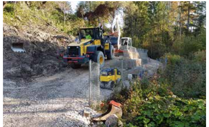
Einbau der Stützkonstruktion und Erosionssicherung am Böschungsfuß
