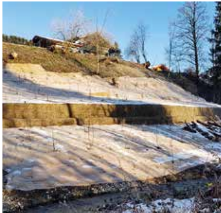
Fertigstellung Böschungssicherung mit Erosionsschutzmatten und Bepflanzung
