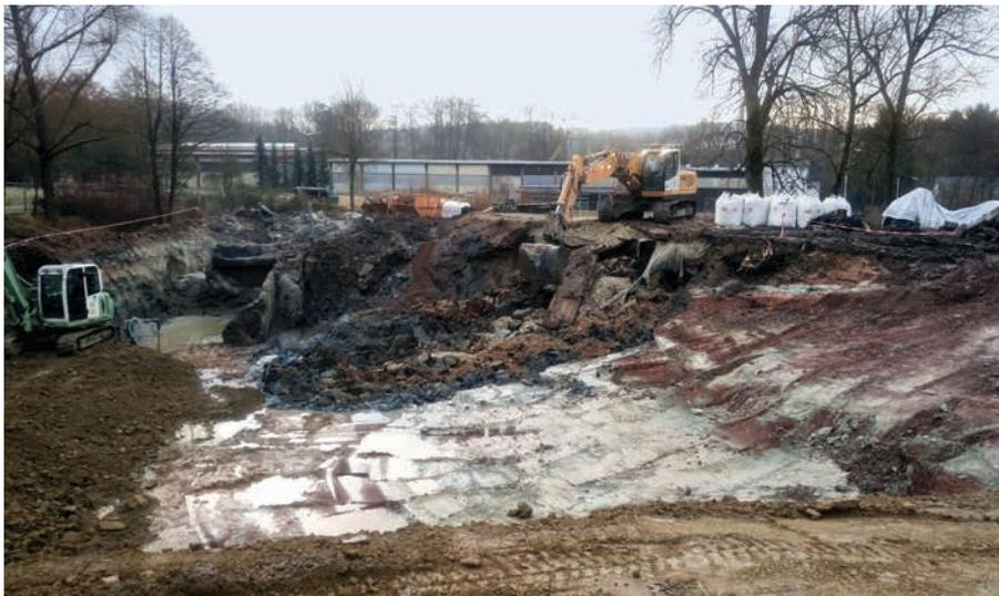
Aushub und Bodeneinbau während der Sanierung im Dezember 2016
