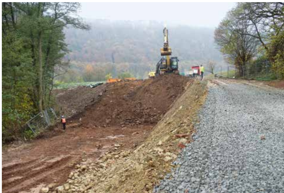
Laufender Aushub der Deponie mit Aushubbasis und offenem Deponiekörper
