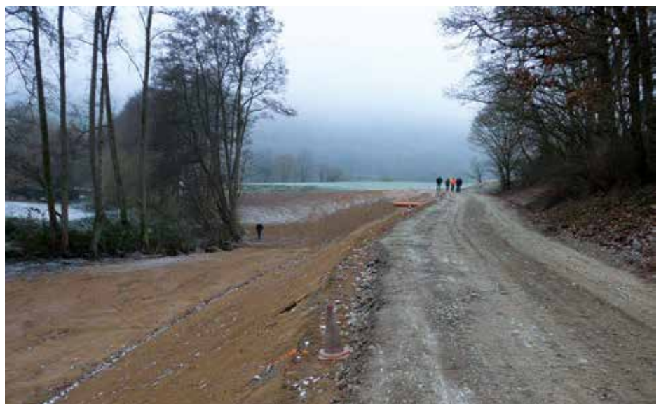
Deponiefläche nach Aushub vor vollständiger Straßenrekonstruktion Blickrichtung Main
