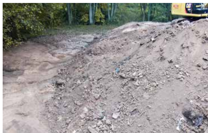
Während des Aushubs – offener Deponiekörper
