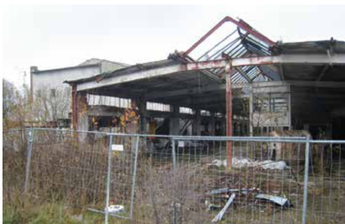
Bild 2: Tunnelofenhalle der ehemaligen Porzellanfabrik Bareuther, Werk A
