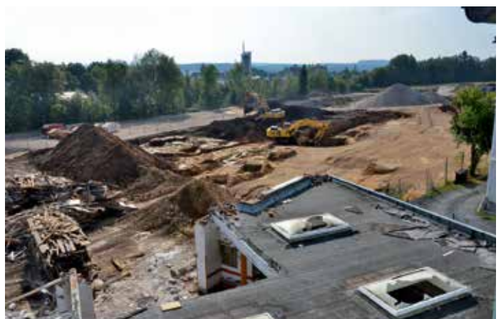
Bild 3: Ehemaliges Bareuther-Gelände während der Bodensanierung Mitte 2016
