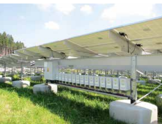
Einzelfundamente ohne Einbindung in den Boden; hier: mit Beton ausgegossene Schachtringe
