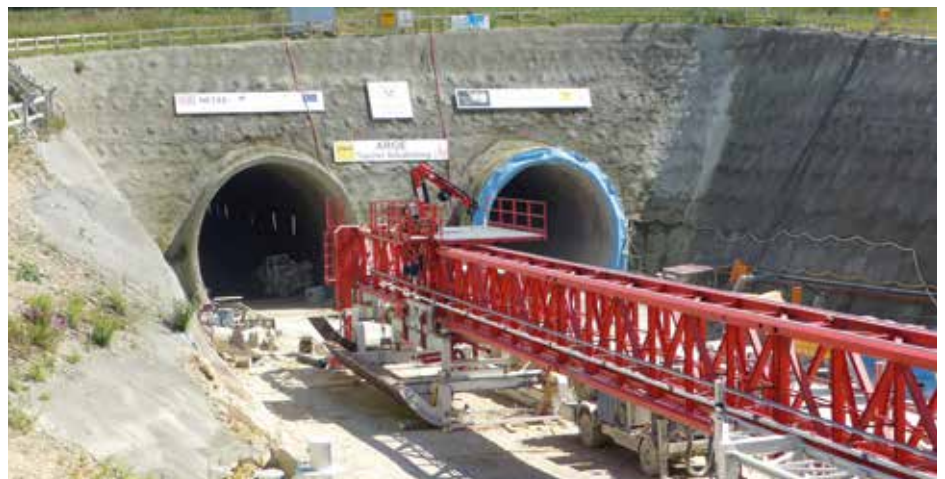
Tunnelbau bei Dornstadt
