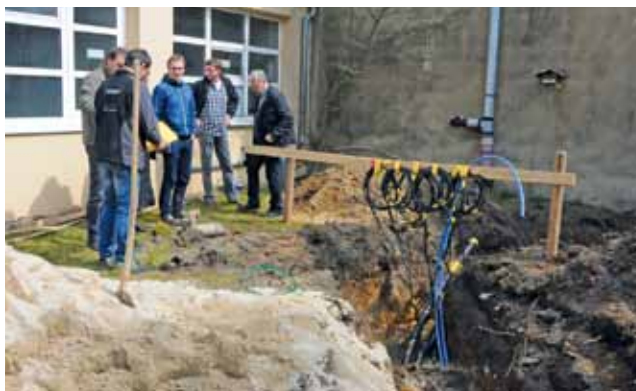
Leitungsverlegung im Innenhof der Polizeidirektion
