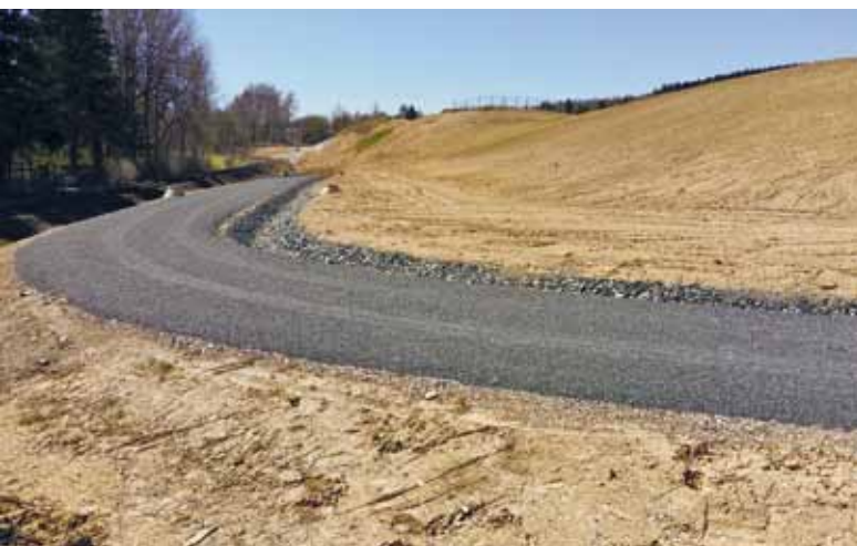
Profilierte und abgedeckte Deponie und östliche Deponieumfahrung mit Randgraben
