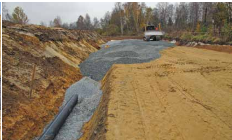
Bau der Sickerwasserrigole östlich der Deponie
