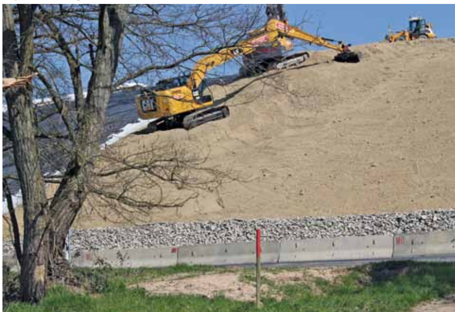
Deponiesanierung Sendelbach, Lohr am Main
