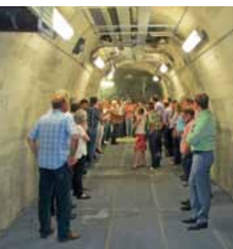
Deponie bei Wirmsthal, Kontrollschacht
