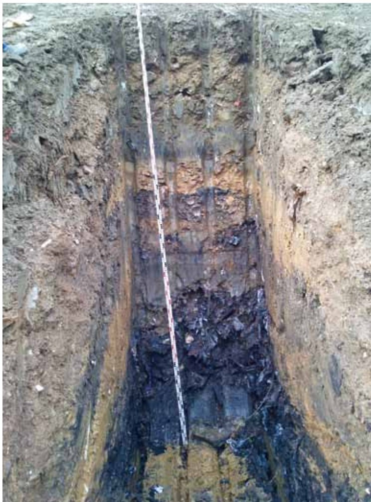
Schurf im Böschungsfuß der Deponie:
