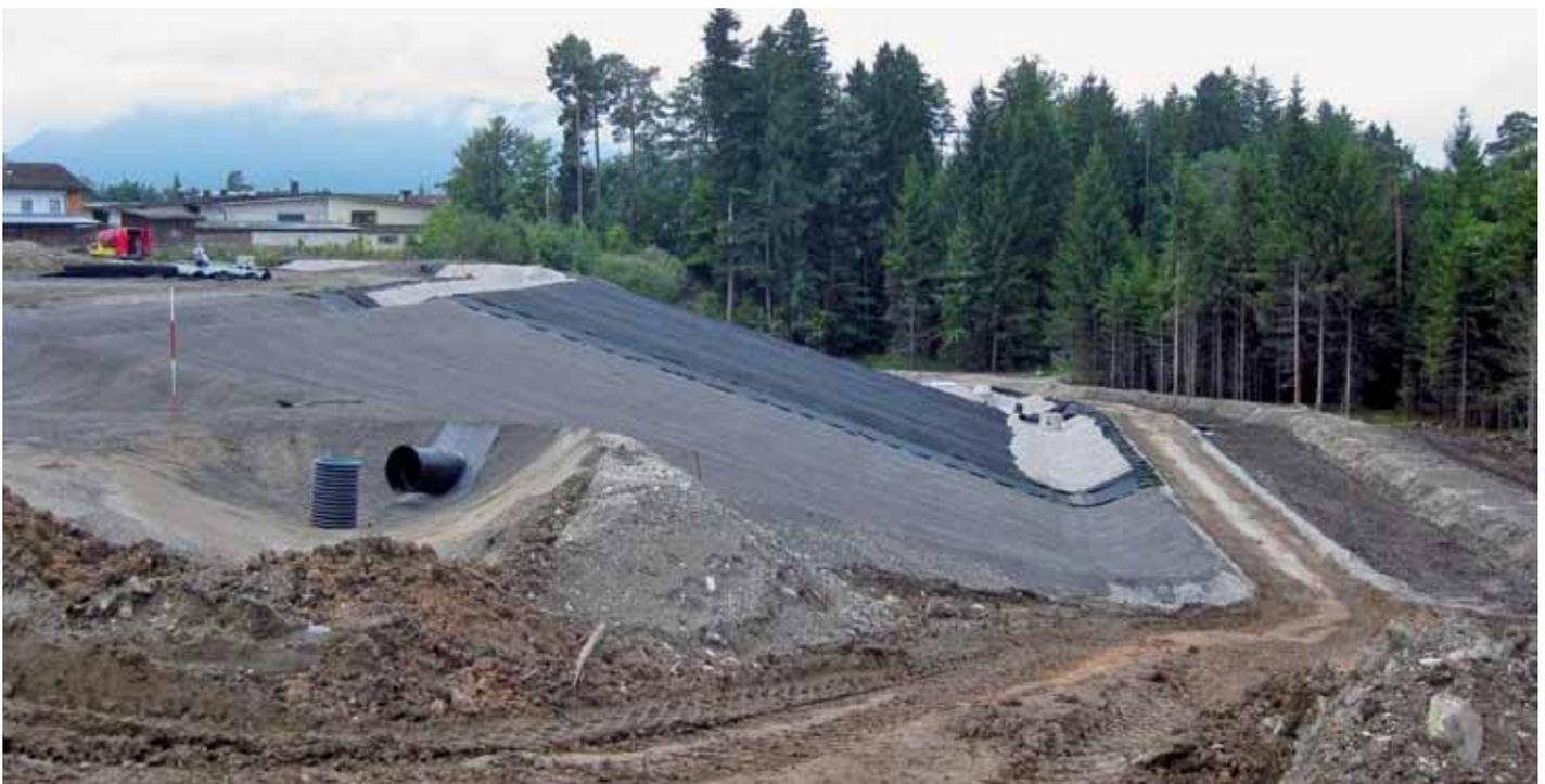
Die Entwässerungsringleitung, die Sickermulde und die Gasbrunnen sind für die Wartung und Probenahme über eine Ringstraße anfahrbar.
