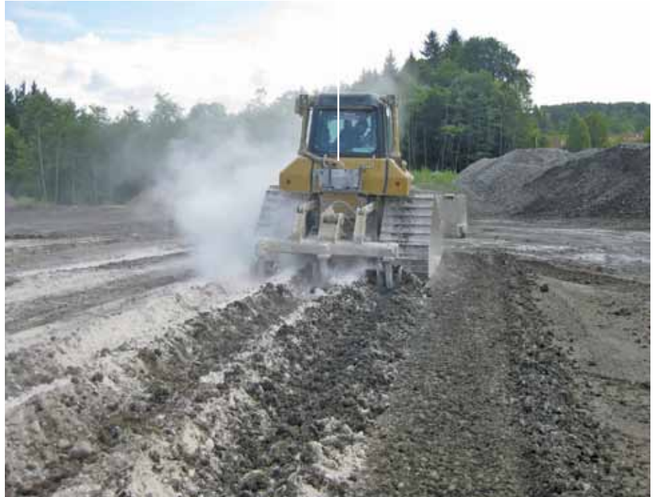
Herstellung der Befahrbarkeit / Bearbeitbarkeit durch Einmischen von Feinkalk
