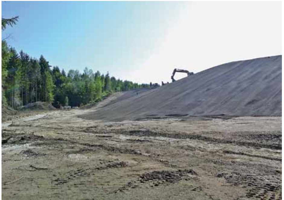
Profilierung der westlichen Abflachung
