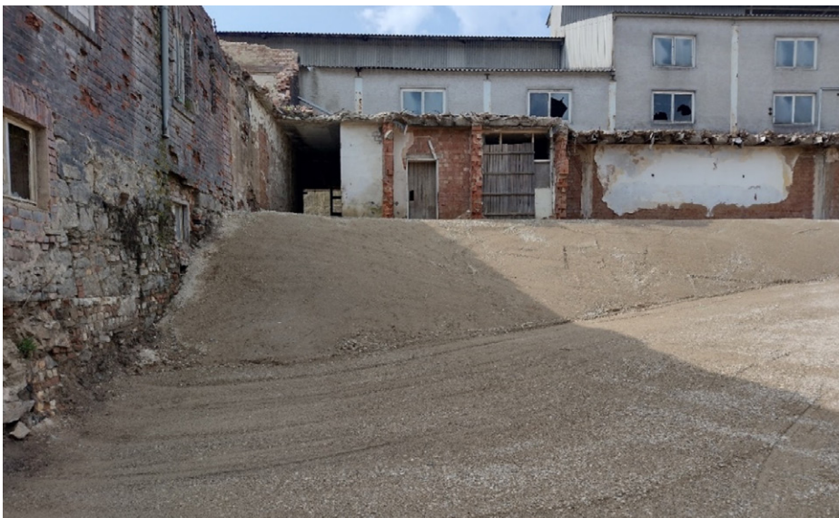
April 2026 – wieder verfüllte Sanierungsgrube im Bereich der Teerbecken (6)
