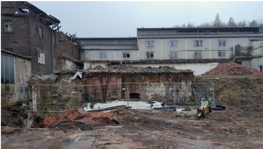
November 2024 – Beginn der Hotspotsanierung: Blick auf die Außenwände des ehem. Kohlebunkers mit vorgelagertem Teerbecken (unter der weißen Plane) (2)
