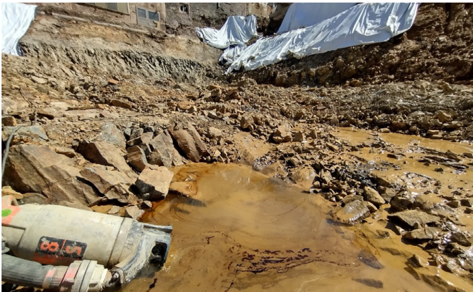
April 2025 – am tiefsten Punkt der Aushubgrube unter den ehem. Teerbecken mit Restkontaminationen am Pumpeneinlauf (5)
