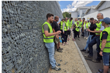
Sicherung der Deponiesteillböschung durch Ausführung mittels bewehrter Erde mit einer Gabionenfront (4)
