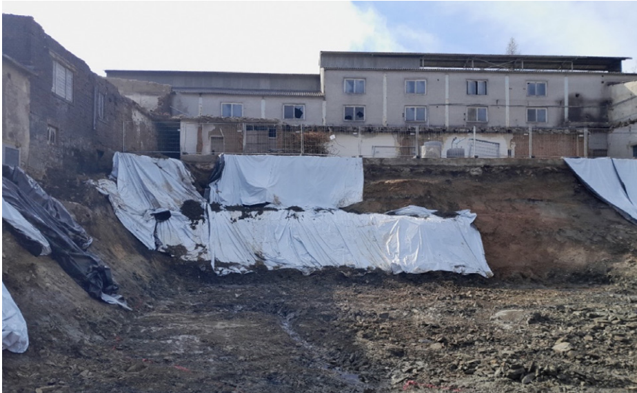
März 2025 – während der Sanierung: Aushub im klüftigen Gneis unterhalb der ehem. Teerbecken (4)
