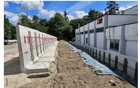
Sicherung der Deponie mit drainierten Winkelstützelementen (5)
