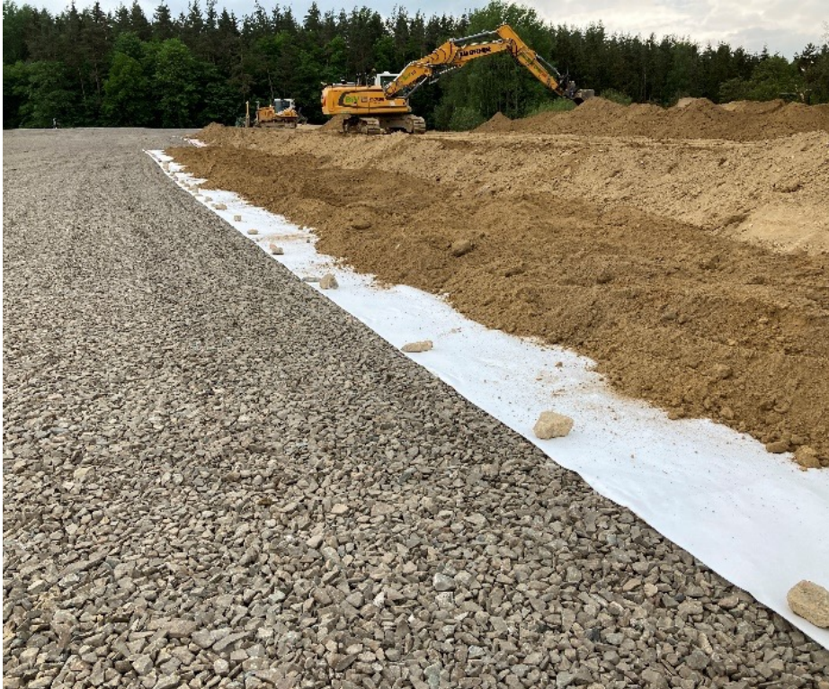
Oberflächenabdeckung im Bau – von links: TAS – Vlies – Boden (2024) (9)
