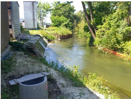
(4) Böschungsbereich mit Spundung der Austrittsstelle im Bildhintergrund sowie provis. Schürfgrube mit perforiertem Betonschachtring zur Absaugung (Sofortmaßnahmen)
