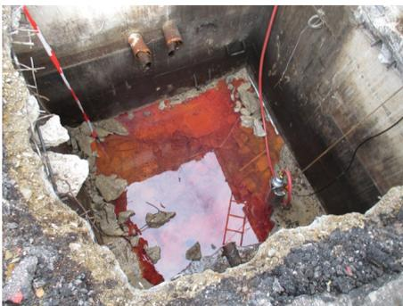
(2) (3) Heizöl-Phase in Schürfgrube und Revisionschacht, Abschöpfung freie Phase über Druckluftpumpen
