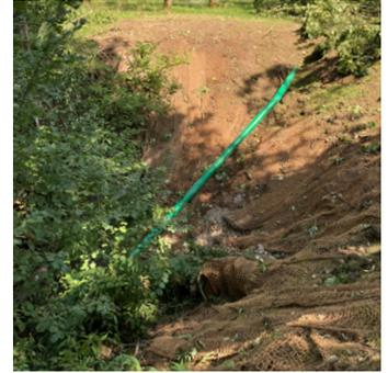
Sicherung der abgerissenen Böschungskante mit Naturmatten und Verlängerung der Ablaufleitung (7)
