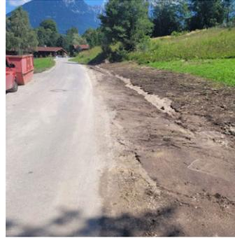
Anschluss des östlichen abgedichteten Grabens an den Oberflächenwasserkanal (6)
