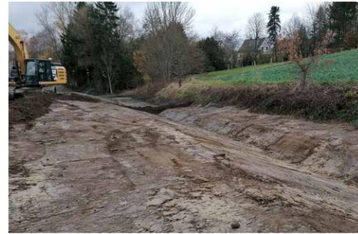
(5) Aufbau der Deponieabdeckung während der Sanierungsdurchführung
