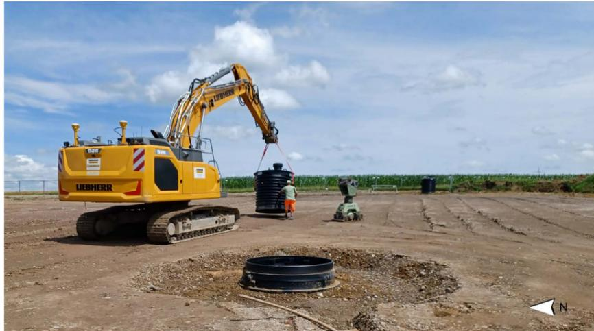
Einbau eines Biofilters
