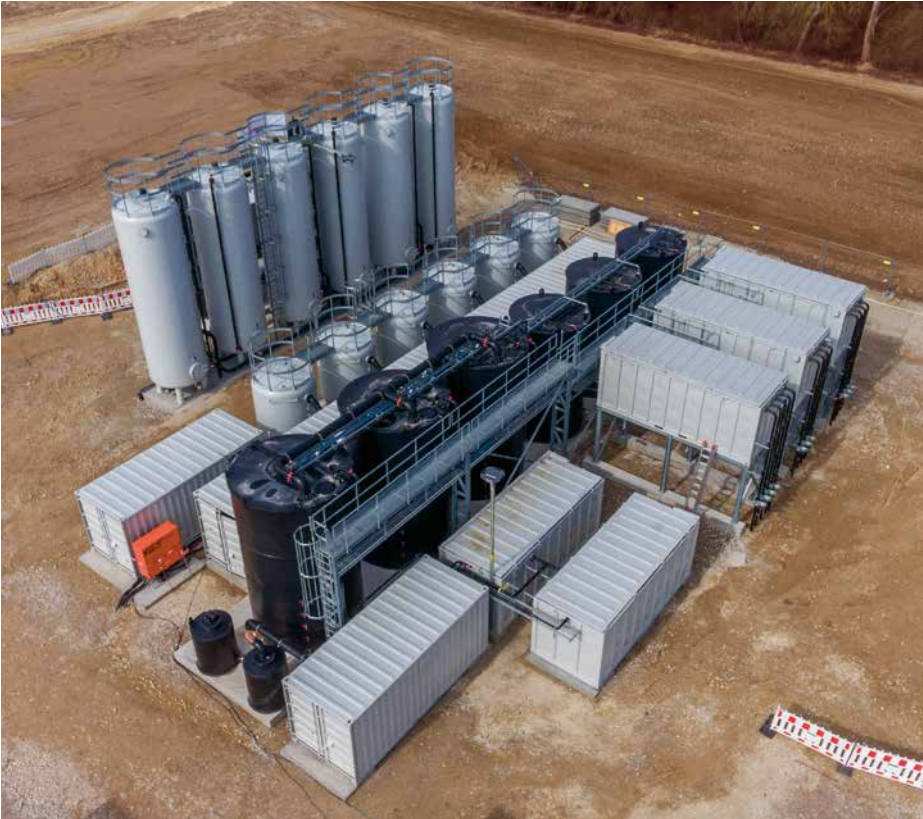
Bild 2) Grundwasserreinigungsanlage
