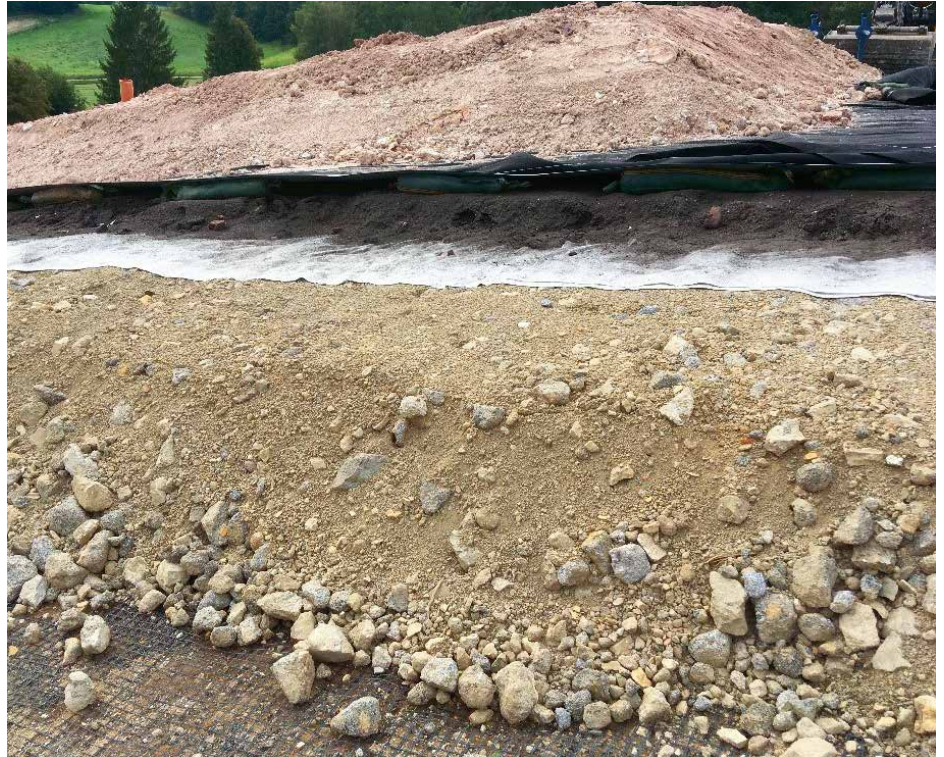
Dichtungsaufbau mit Ersatzbaustoffen unter KDB
