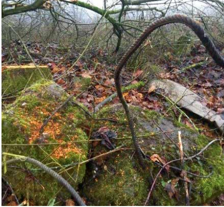
Deponieböschung vor Sanierung
