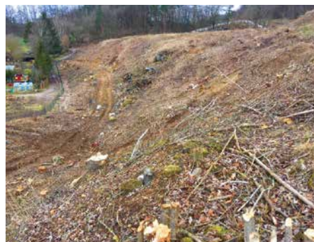
Deponiesteilböschung nach Rodung
