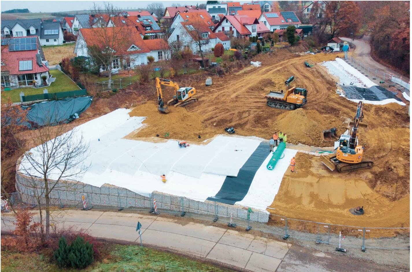
Überdeckung der Abdichtungskomponenten mit Reku-Boden zum Aufbau einer Wasserhaushaltsschicht
