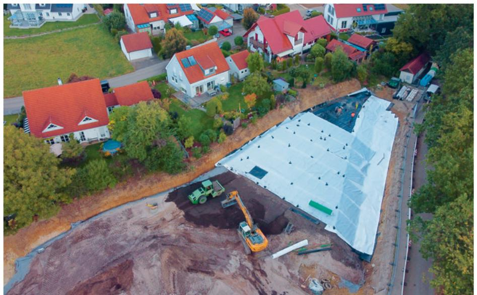
Herstellung Gasdränageschicht aus Gießereisand mit kontinuierlicher Überdeckung durch Vlies und Kunststoffdichtungsbahn
