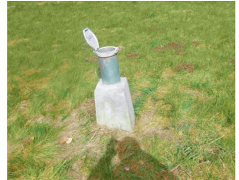
2) Angefahrene Messstelle, in ca. 0,5 m Tiefe ist das Vollrohr abgesichert – direkter Zufluss von Oberflächenwasser in das Grundwasser ist gegeben.
