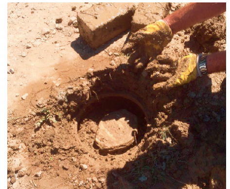
4) Freigelegte Messstelle, nach Suche mit Metalldetektor.
