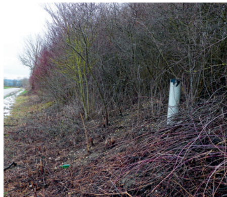
3) Beschädigte Messstelle, fehlende Abdeckung.
