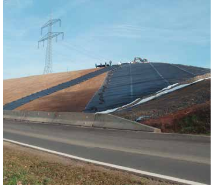
Westliche Deponieböschung während Sanierung 2014 - Aufbringung der Kunststoffdichtungsbahn
