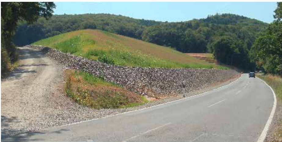
Deponie Westböschung nach Sanierung 2017 (Blick von oben auf Maintal)
