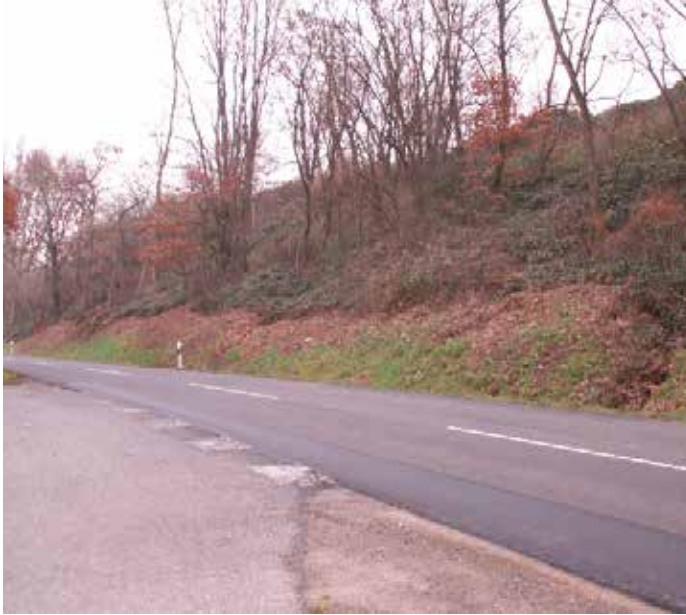
Deponie Westböschung vor Sanierung 2012 (Blick von unten)
