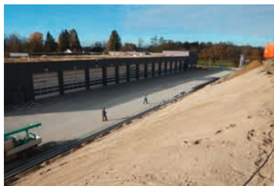
Abb. 8: Aufbringen einer steinfreien Sauberschicht auf der Südböschung des Lärmschutzwalls, angrenzend Feuerwehrgelände
