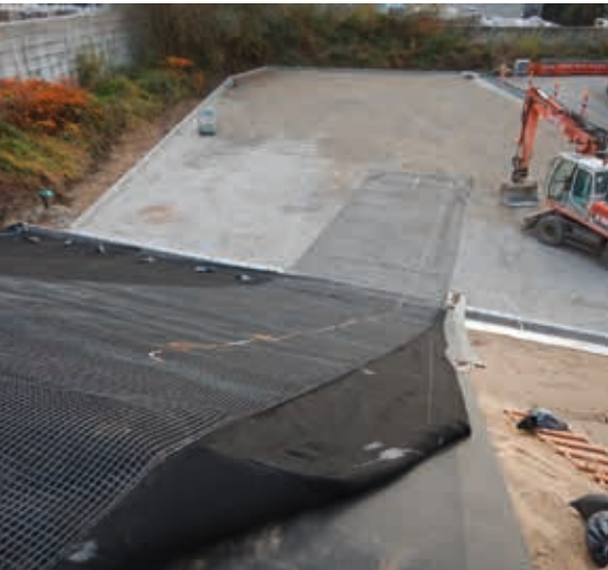
Abb. 9: Verlegung von KDB, Drainmatte und Geogitter auf der Südböschung des Lärmschutzwalls
