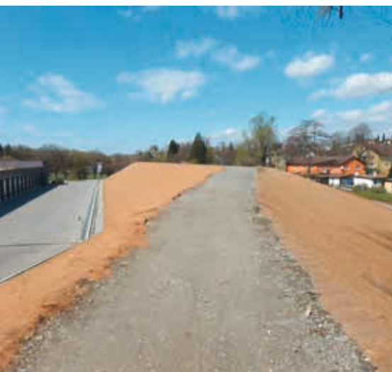
Abb. 11: Abdeckung des Oberbodens mit Kokosmatten zur Erosionssicherung
