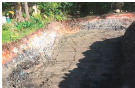
Abb. 7: Aushub entlang des Rickenbachs
