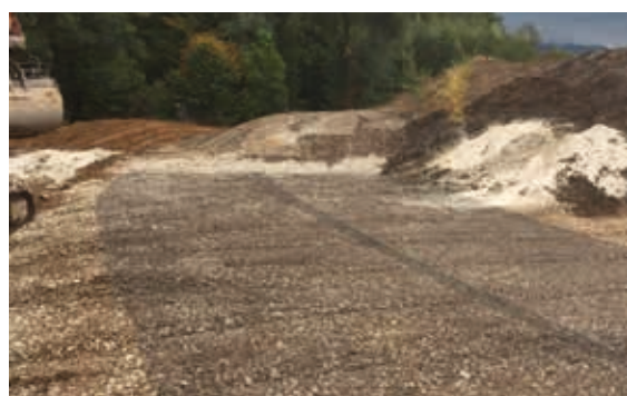
Abb. 6: Bettungspolster mit Geogitter und flächiger Einstreu von Dorosol zur Stabilisierung des darüber umgelagerten Bodens
