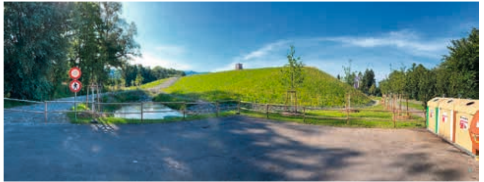
Abb. 12: Sanierungsfläche im Juli 2021; Blick nach Südosten
