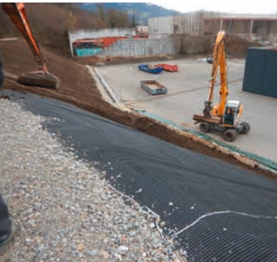
Abb. 10: Andeckung mit Oberboden auf der Südböschung des Lärmschutzwalls
