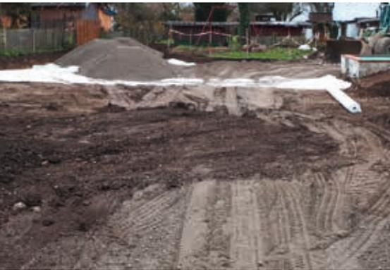
Aushubsohle, Aufgebrachtes Geotextil und Kies
