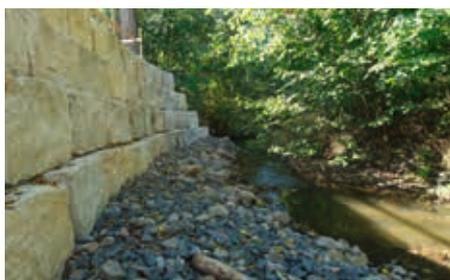
Abb. 2 Nach der Sanierung mit Blocksatzmauer gesicherter Prallhang der ehemaligen Hausmülldeponie
