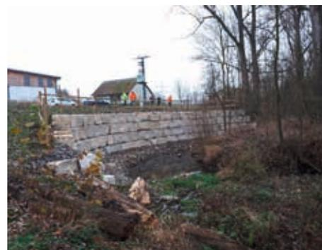
Abb. 7 Mit Blocksatzmauer gesicherter Prallhang der ehemaligen Hausmülldeponie
