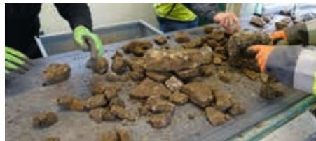
Abb. 6 Behandlung des Deponats / manuelle Auslese von Schwarzdeckenresten am Sortierband
