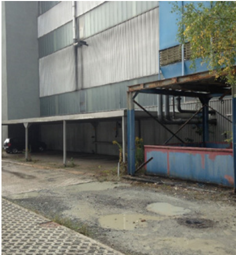
Abb 2.: Ostseite des HELOTEX-Gebäudes mit PER-Tankwanne und Grundwassermessstelle GWM 4
