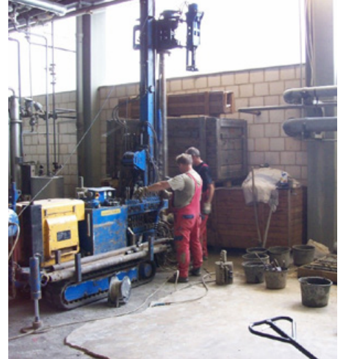
Abb. 4: Errichtung der Grundwassermessstelle GWM 7
