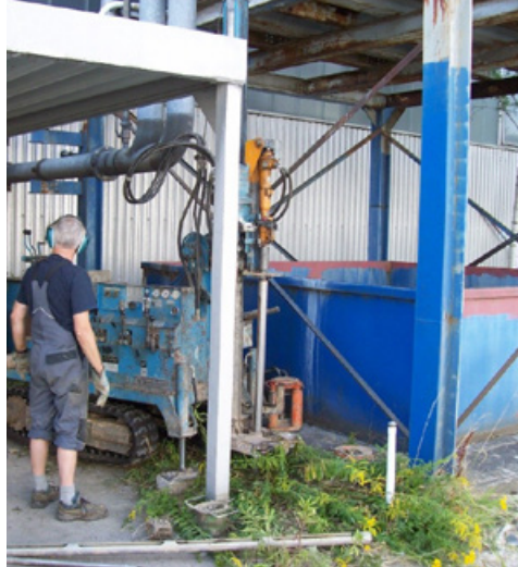
Abb. 3: Abteufen von Rammkernsondierungen am ehemaligen PER-Tank
