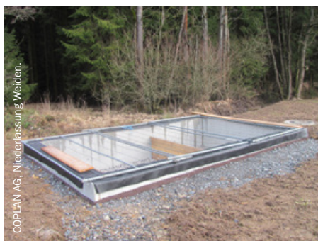
Pufferbecken, optional mit Kiesfilter geeignet zur Sickerwasserbehandlung
