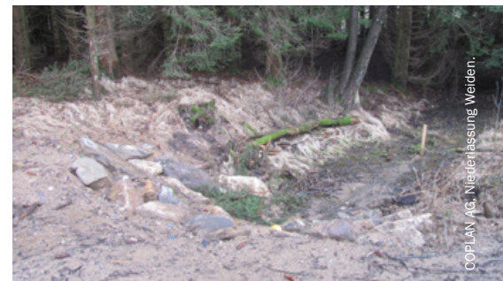
Auslauf des Kanals zur Sickerwasserableitung
