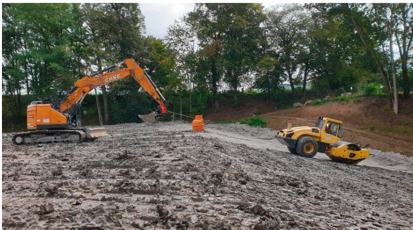
Einbau der mineralischen Dichtung im Böschungsbereich mit Sicherung des Walzenzuges
