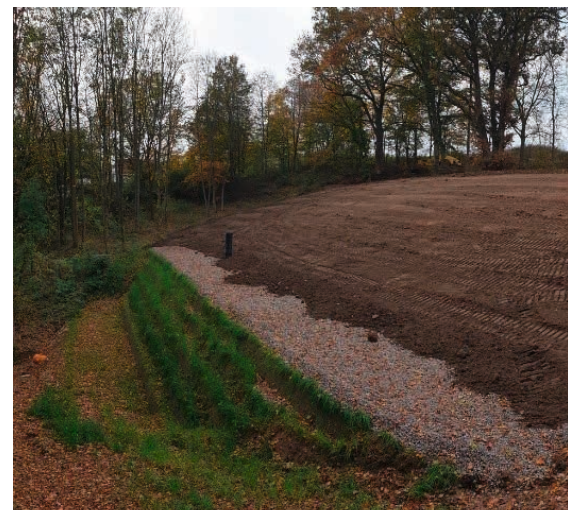
Sanierter Deponiebereich nach Auftrag Oberboden
