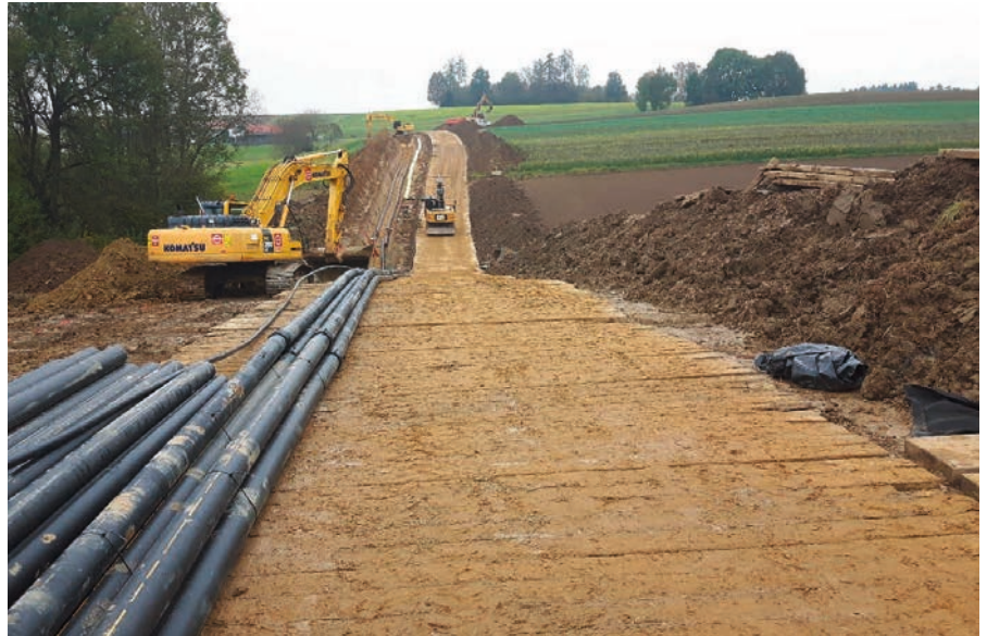
Beispiel einer Erdkabelverlegung mit Bodenkundlicher Baubegleitung
