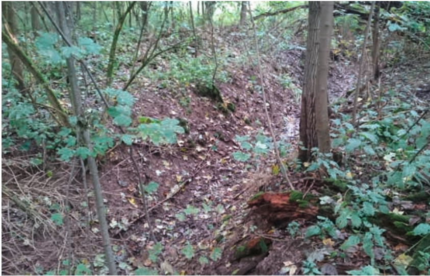
Graben auf der Deponieoberfläche
