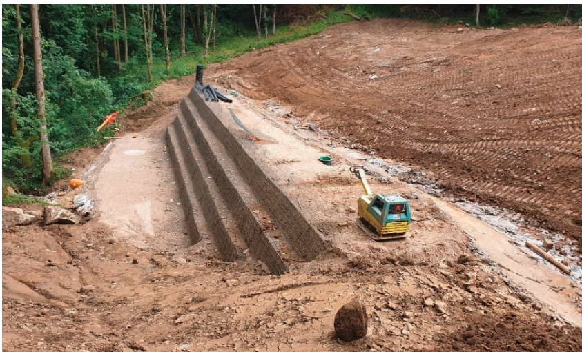
Einbau der Stützkonstruktion am Böschungsfuß
