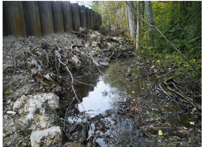
Naturnahe Gestaltung des neuen Uferbereichs. Die Arbeitsvorgabe lautete: Es soll „möglichst wild“ aussehen.
