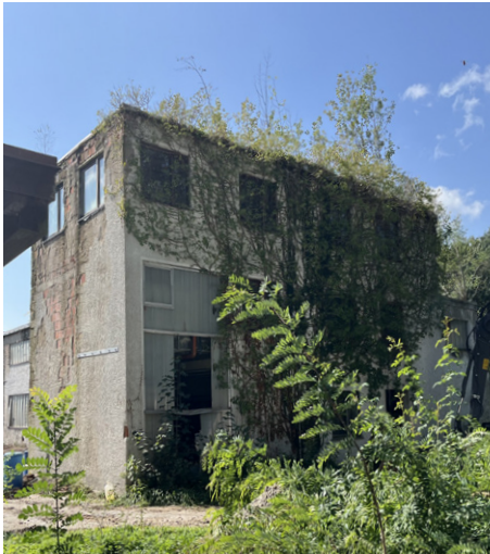
Eingangsbereich des Betriebsgebäudes zu Beginn der Rückbauarbeiten (2)
