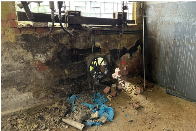
Innenansicht Sektor 3 (Hartverchromung) mit Chromatkontamination (4) (5)
