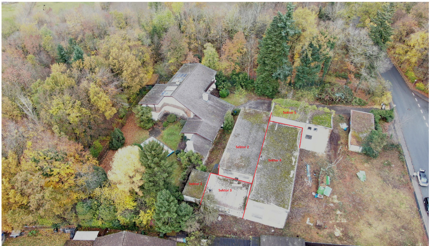
Betriebsgebäude mit Markierung der Bauteile (1)
