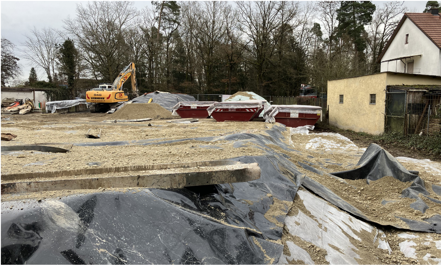
Provisorische Abdeckung des Baufelds mit KDB-Folie während der Winterpause (6)
