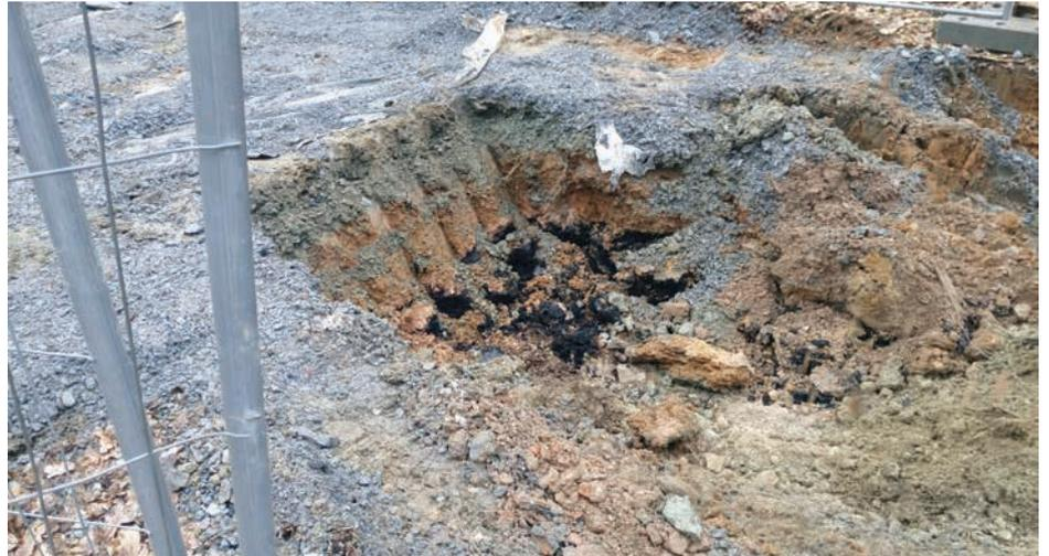
Randbereich der Sanierungsfläche mit geringmächtigen Ausläufern der Säureharzschicht
