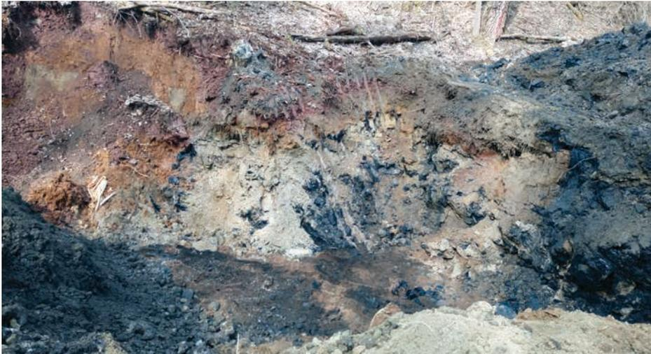
Blick in Baugrube mit „Wechselagerung“ Sand / Säureharz
