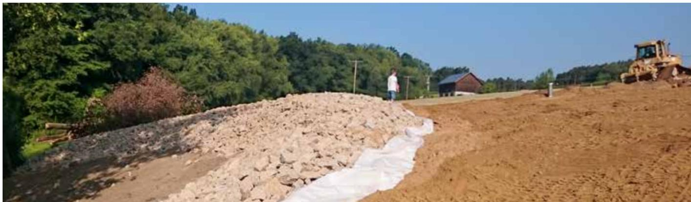
Ausgeführte Erosionssicherung zum Biotop (Bauzustand)
